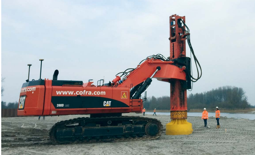
Figuur 9 - CDC uitvoering op het werkeiland (9-1-2018).
