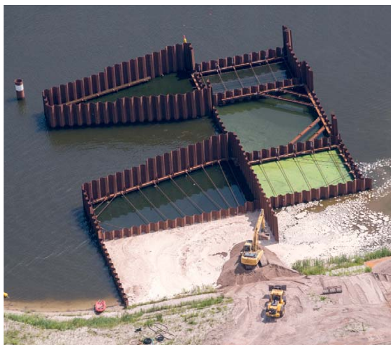
Figuur 5 – Overzicht ombouwfase (5-7-2017) t.b.v. aansluiting Fase 2.
